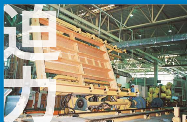
大型工作機械による組立て
