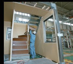
設備取り付け
